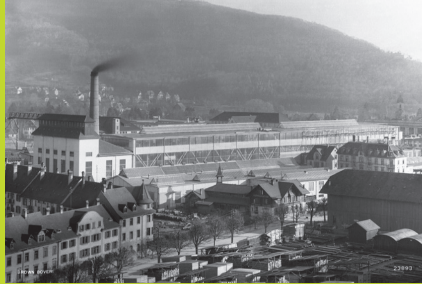
Halle 30, kurz vor Fertigstellung, um 1927. (Historisches Archiv ABB Schweiz)
